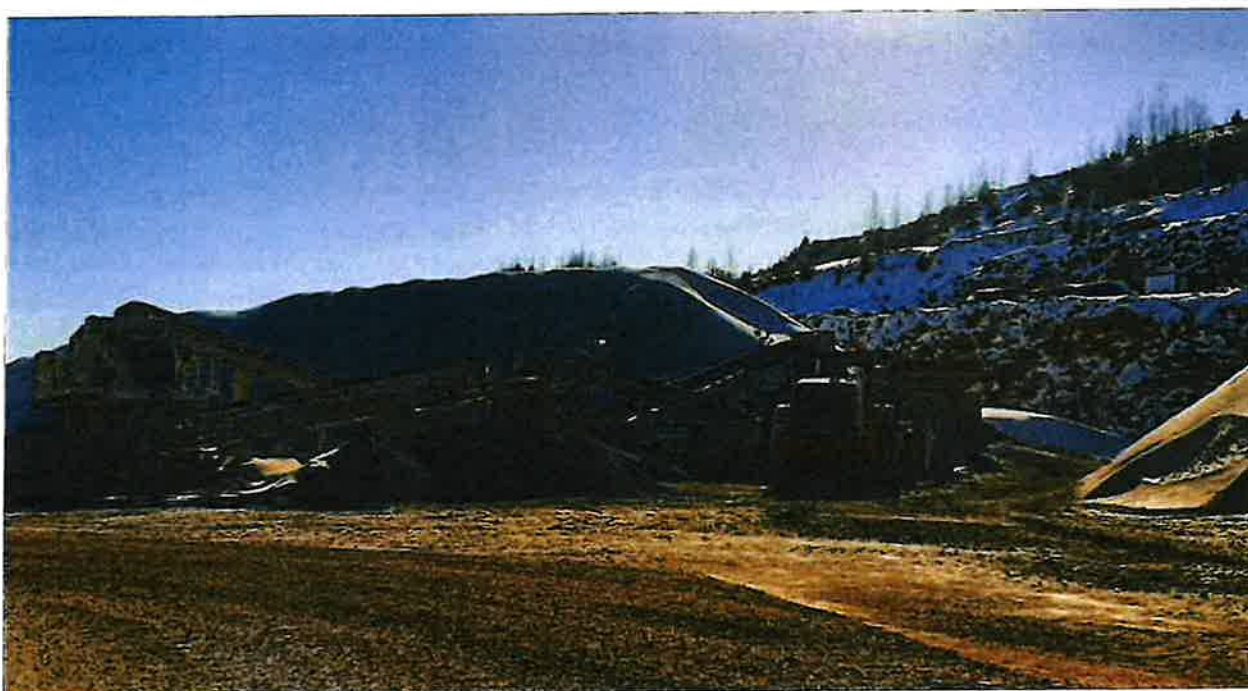
Kuva 3. Jälkimurskain ja seulasto kiinteistöllä Peltola II 505-409-5 1566 Esimurskattua kiviainesta ajetaan jälkimurskaimelle pyöräkuormaajalla.
