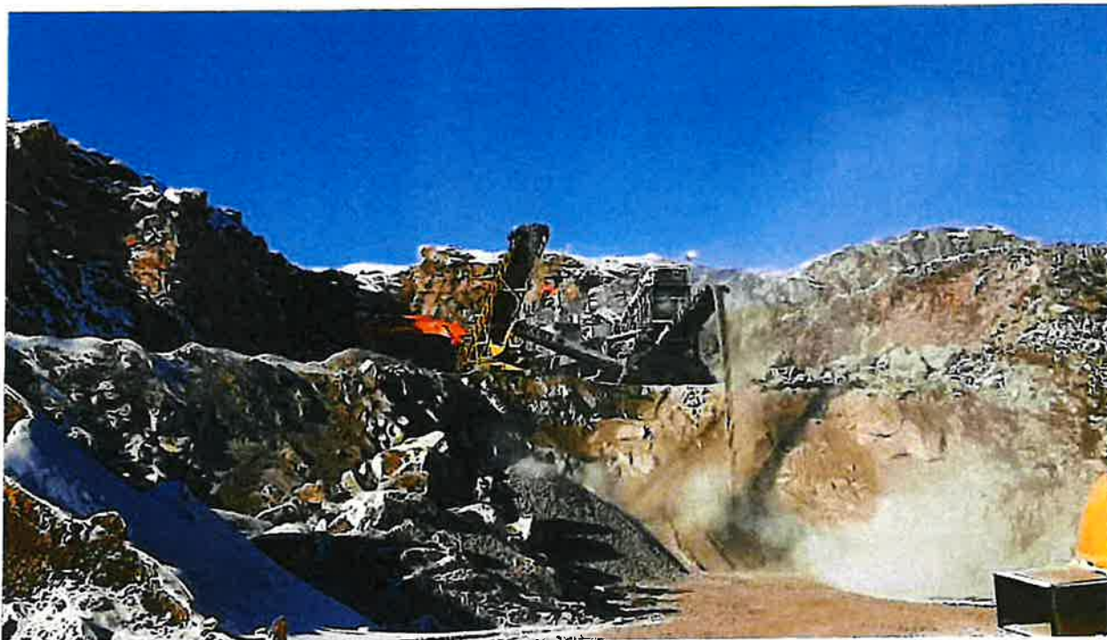
Kuva 2. Esimurskain ja kaivinkone kiinteistöllä Kalliorinne I 505 409 5 287. Esimurskaimesta lähtee kaksi kuljetinta
